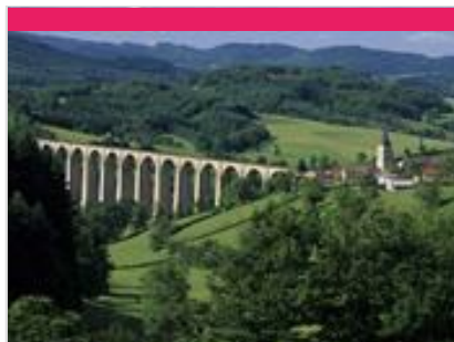
Viaduc de Mussy-sous-Dun
