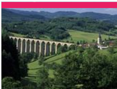
Viaduc de Mussy-sous-Dun
